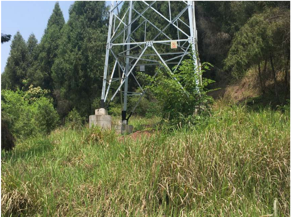
塔基占地区植被恢复状况 1
