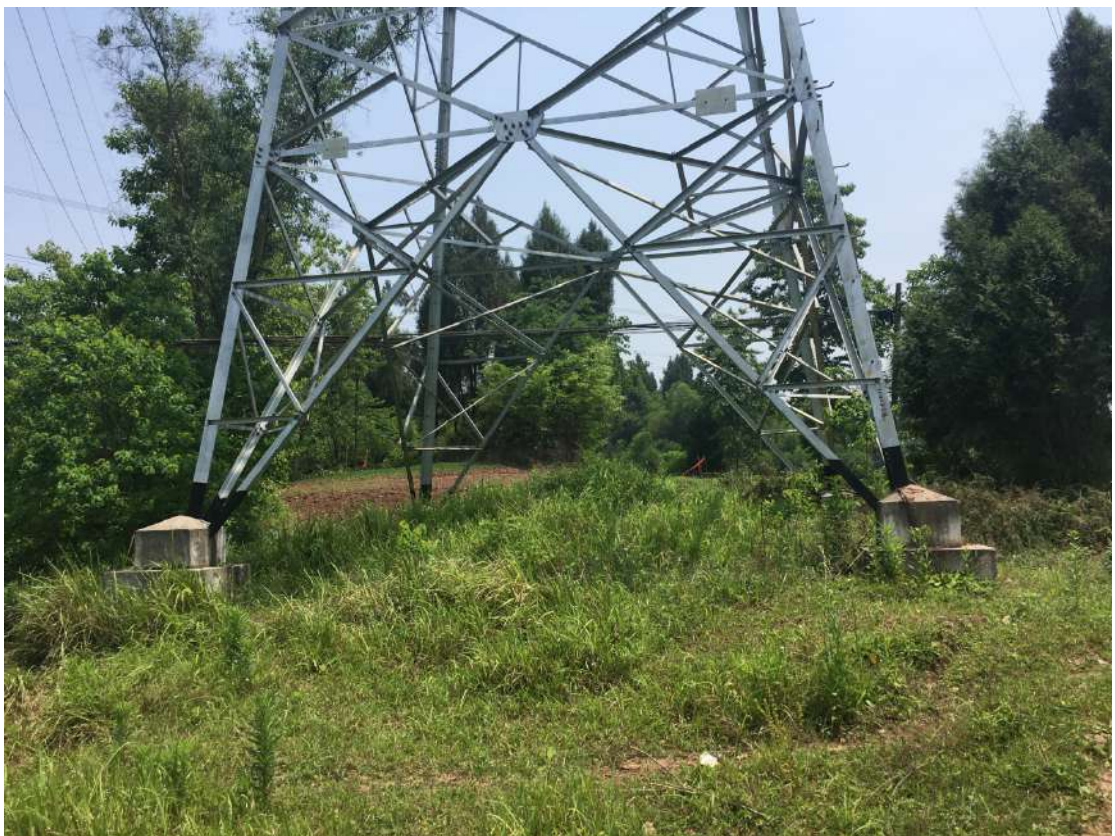
塔基占地区植被恢复状况 2
