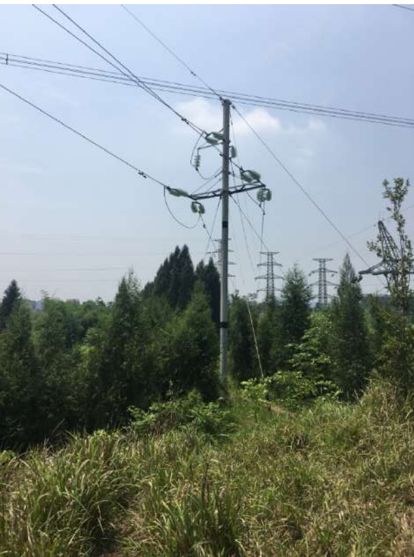
渠县南阳庆丰至龙潭 35kv 线路工程新建杆塔 38 基（其中新建直线塔 8 基，新建耐张塔 14 基，新建直线水泥杆 13 基，新建耐张水泥杆 3 基）
